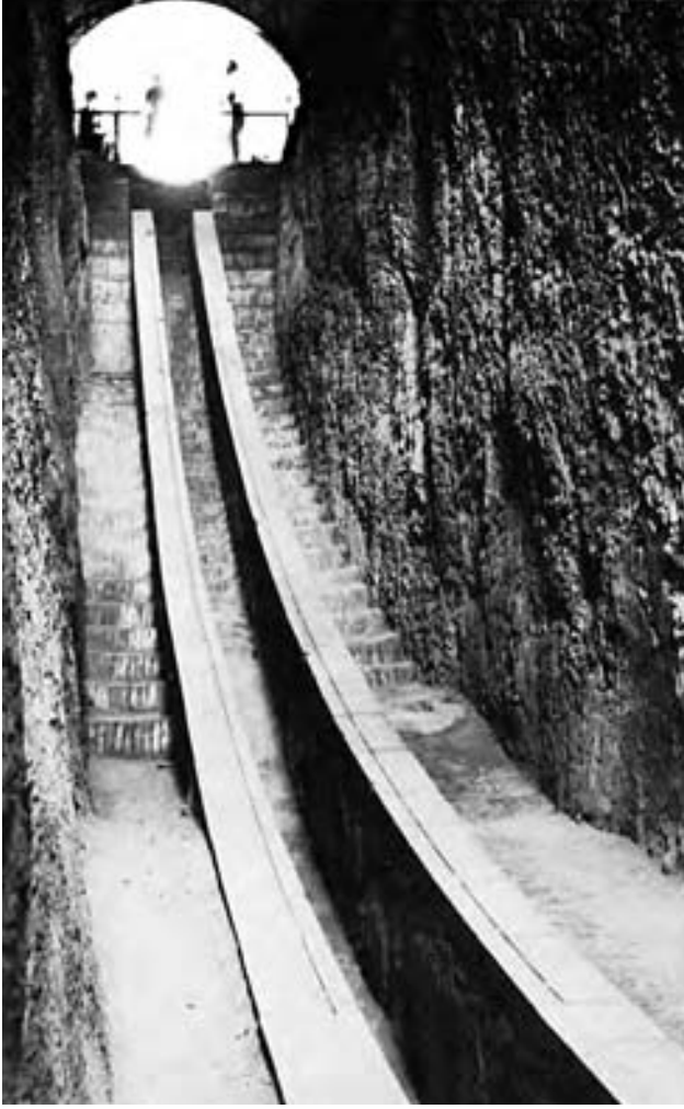
Kazılar sonrasında Semerkant Rasathanesi'nin kısmen restore edilmiş sekstantı. (Sağ üstte: Modelimiz. Kesit).
