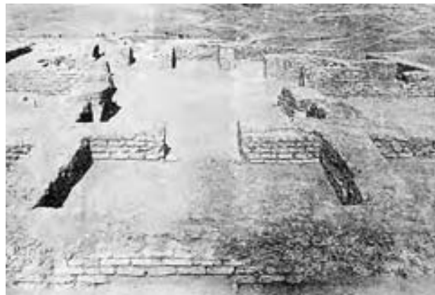
Tahmin edilen kütüphane binasının temel duvarları.
