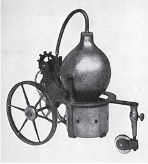
P.M. Grimaldi'nin buharlı arabasının rekonstrüksiyonu.
