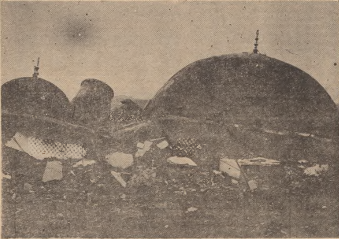
Gediz'in 400 yıllık Ulu camii'nin zelzeleden sonraki hali. Ulu Camii'nin de kubbesi elle konmuş gibi yere inmiştir. Cami duvarındaki Muhammed (C.A.S.) levhası gene mihrabın yanında asılı durmaktadır. İlgililerden Ulu camii'nin tarihî tezyinatına uygun olarak yeniden inşa etmelerini isteriz. Deprem felâketzedelerine olan borçlarını ancak böyle ödeyebilirler.
