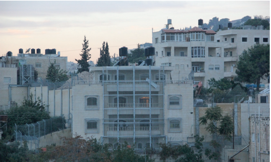
Foto 2. Ayzeriye'de bir "Duvar Ev" (Kasım 2012)
