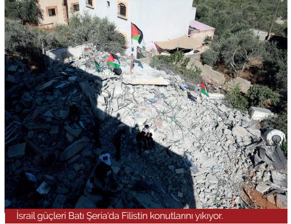
İsrail güçleri Batı Şeria'da Filistin konutlarını yıkıyor.
